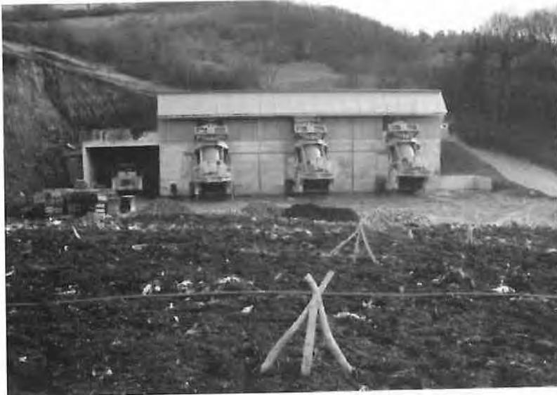
Die lichte Breite der Rutschen und der Durchmesser der Mischtrommeln beträgt ca. 3 m, so daß alle sperrigen Teile zwangungsfrei in die Trommeln eingefüllt werden können.
