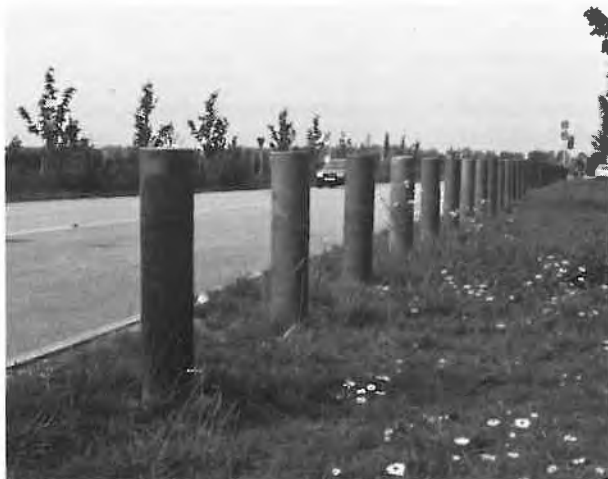
Bild 5.30 Begrenzungspfähle aus Sekundärkunststoffen der Fa. WKR hergestellt im Spritzgießverfahren
