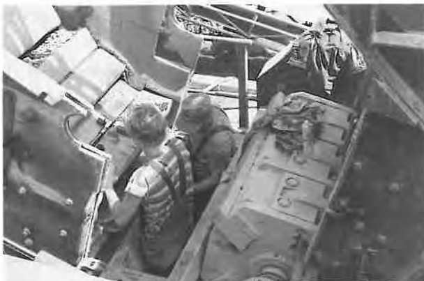
Bild 2.5. Wartungsarbeiten an einer Prallmühle von Orenstein & Koppel, Bauschuttaufbereitungsanlage Firma Hafemeister
