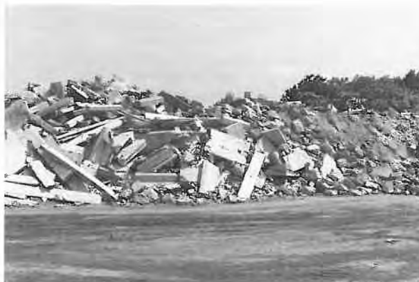
Bild 1.1. Betonabbruch aus dem Hochbau
