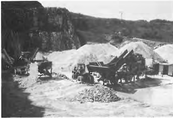
Bild 2.4. Mobile Bauschuttaufbereitungsanlage Typ Kleemann + Reiner im Betrieb (Fa. Hebel)
