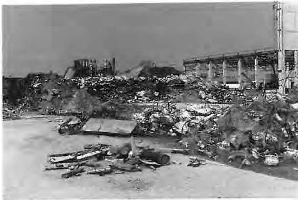
Bild 1.2. Betonabbruch im Industriebau. Im Vordergrund Monierstahl, Holz, Abflußröhren etc.
